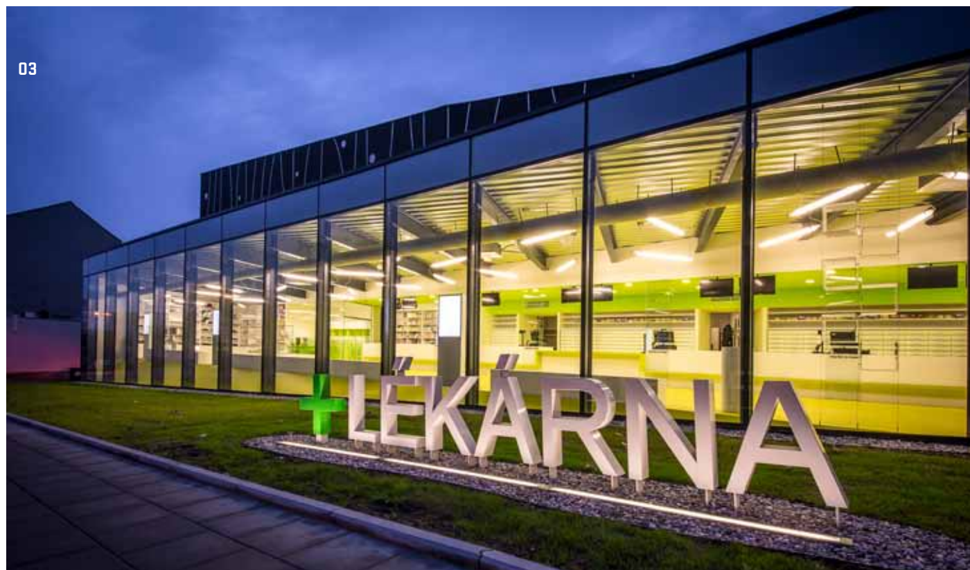
03 > Prosklená fasáda: atypicky tvarované bezpečnostní izolační dvojsklo s prostupností světla 65 %, reflexí 11 %, stínícím koeficientem max. 0,45 a součinitelem prostupu tepla U_g = 1,1
