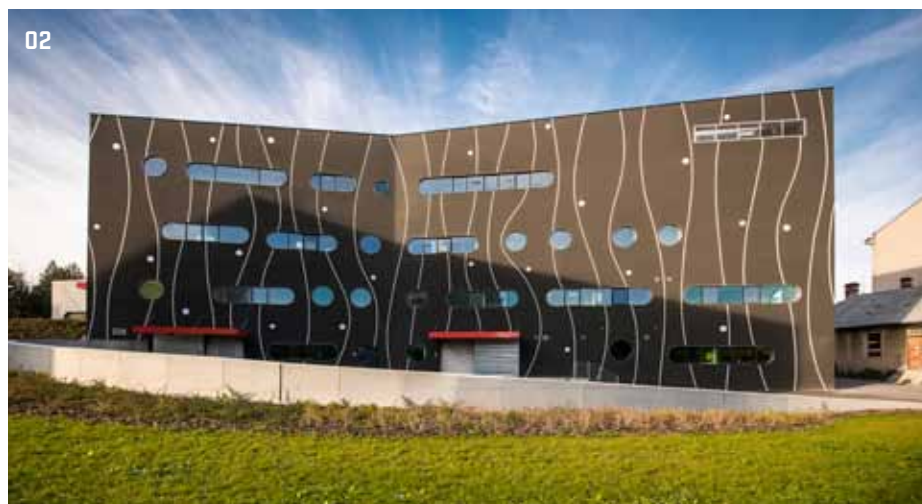
02 > Díky svažitému terénu se podařilo zajistit zásobování centrálního skladu léčiv v zadní části budovy
